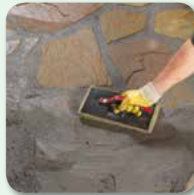
diagonal zur Fuge abreinigen
