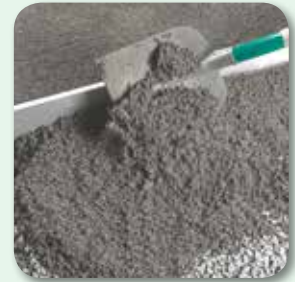
Mörtel aufbringen und über Lehren abziehen
