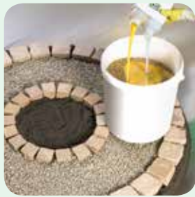
Splittbinder dem Mineralstoff zugeben
