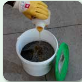
Bindemittelkomponente zugeben
