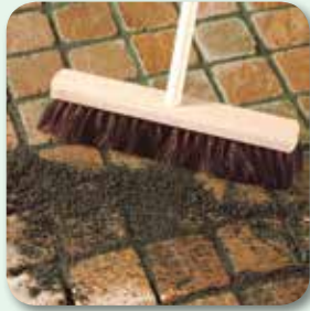
mittels feuchtem Besen abfegen
