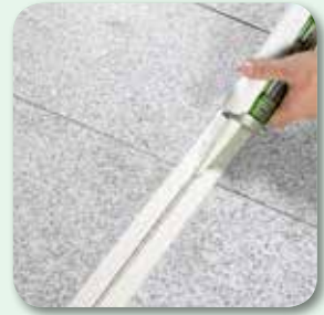
Fugenmasse einbringen
