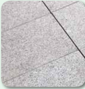
Oberfläche und Fugenflanken vorbereiten
