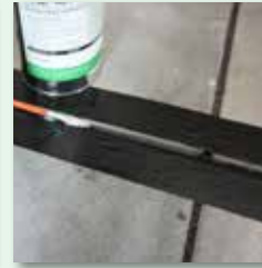
Fugenflanken mit Primer grundieren
