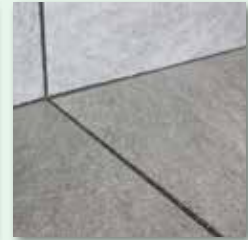
Nach vollständiger Erhärtung überschüssigen Sand entfernen.
