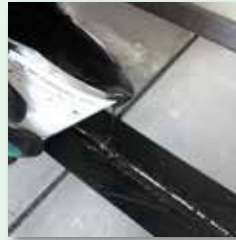
vdw 380 PolyfugenFlex in die Fuge gießen
