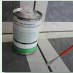
Fugenraum säubern und Fugenflanken primern
