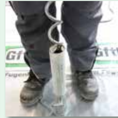
Komponenten in der Kartusche im Gebindehalter mischen
