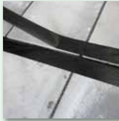
Fugenraum säubern und Kanten abkleben
