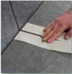
Oberfläche säubern und Kanten abkleben
