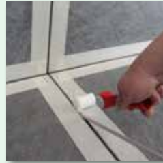
Fugenfüllprofil \geq 10 mm eindrücken
