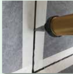
Fugenverschluß bei senkrechten und waagerechten sowie Eckfugen
