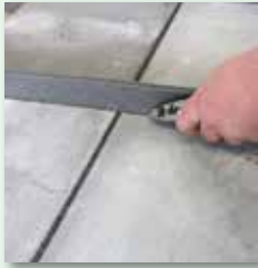
Dehnungsfugenband \geq 10 mm tief freischneiden
