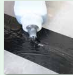
Ggf. umfüllen in die Flasche und vergießen
