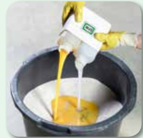
Bindemittelkomponenten zugeben
