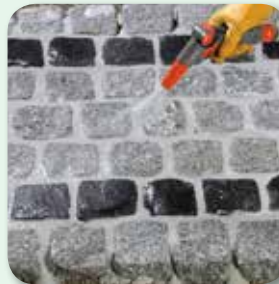
mit Wassersprühstrahl und feuchtem Besen abreinigen
