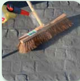
Erhärten des Mörtels auf der Oberfläche vermeiden
