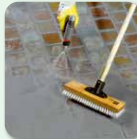
diagonal zur Fuge abreinigen
