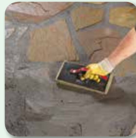
diagonal zur Fuge abreinigen
