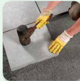
Verlegung „frisch in frisch“
