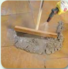
Mörtel mit Hartgummischieber und Wassersprühstrahl einarbeiten
