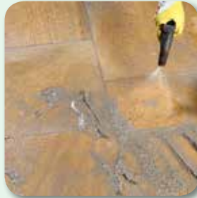
Oberfläche mit weichem Wassersprühstrahl reinigen
