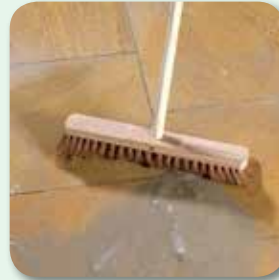
letzte Mörtelreste ggf. mit Kokosbesen entfernen
