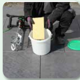
Viskose-Schwammauflage aus dem Eimer entnehmen
