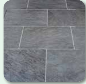
Fertige Oberfläche (ggf. Nachbehandlung beachten)
