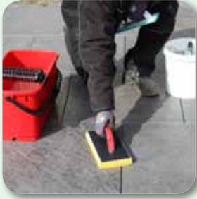
Fläche mittels Schwambrett vornässen
