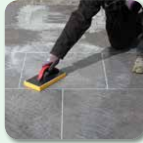
Fugen glätten und Oberfläche rückstandsfrei abwaschen
