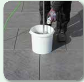
Bindemittelkomponente zugeben und homogen vermischen
