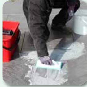
Fugenmörtel mit dem vdw-Fugbrett in die Fugen einarbeiten
