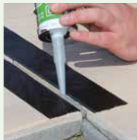
Kanten sauber abkleben und vdw 885 FugenFlex mit Druck blasenfrei einspritzen
