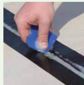
Fugenmasse verdichten und abziehen
