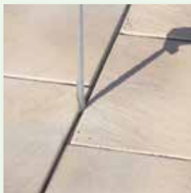
Fugenbandreste komplett entfernen
