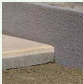
Anschließend den Belag druckfrei verlegen
