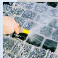
mit Wassersprühstrahl und feuchtem Besen abreinigen
