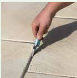
Hierzu Schnittkante FugenBand einkerben
