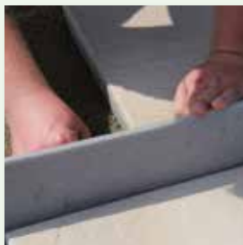
vdw 884 FugenBand im Bettungsmörtel einbringen
