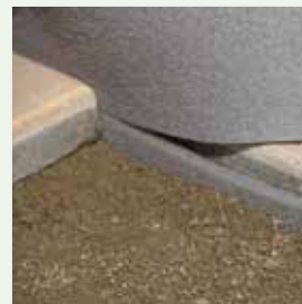
vdw 884 FugenBand 10 mm tief abtrennen
