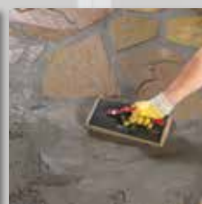
diagonal zur Fuge abreinigen
