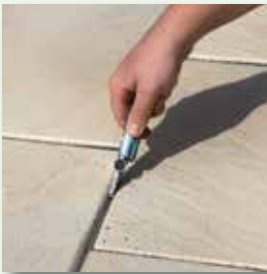
Hierzu Schnittkante FugenBand einkerben
