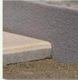
Anschließend den Belag druckfrei verlegen
