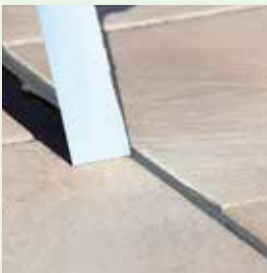
Klebebänder direkt im Anschluss entfernen
