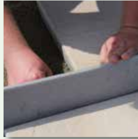
vdw 884 FugenBand im Bettungsmörtel einbringen
