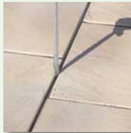
Fugenbandreste komplett entfernen
