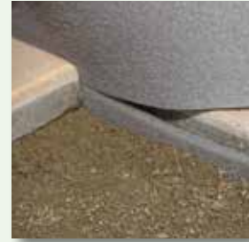
vdw 884 FugenBand 10 mm tief abtrennen
