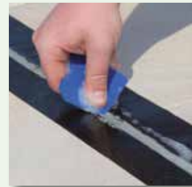
Fugenmasse verdichten und abziehen
