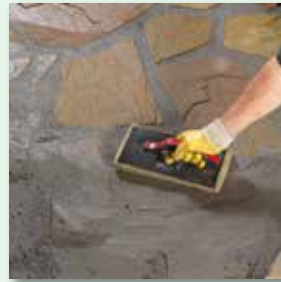
diagonal zur Fuge abreinigen
