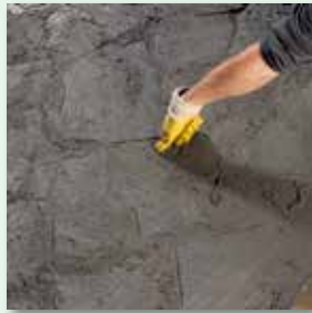
Prüfung Fugendrucktest
