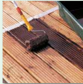
Auftragen der Decksicht mittels Fellrolle und ...
