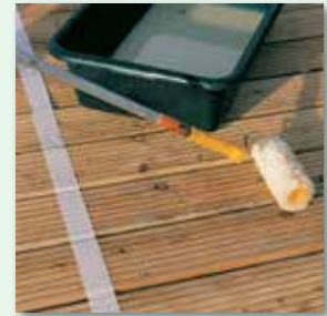
Mittels Fellrolle verteilen
