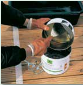
Frühens nach 4 Stunden die Komponenten der Decksicht wie die der Schwimmschicht aufmischen
