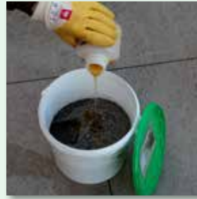
Bindemittelkomponente zugeben
