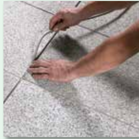
Fugentiefe durch PE-Rundschnur fixieren
