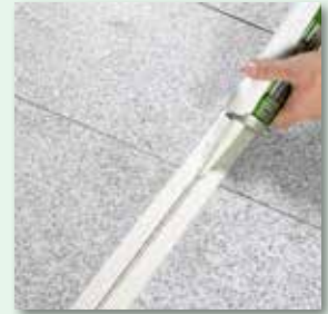
Fugenmasse einbringen
