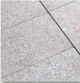
Oberfläche und Fugenflanken vorbereiten
