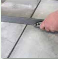
Dehnungsfugenband  $\geq 10$  mm tief freischneiden
