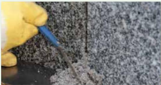
Durch eine Verminderung des Anmischwassers kann vdw 800 für senkrechte Fuge auch spachtelfähig angerührt werden.
