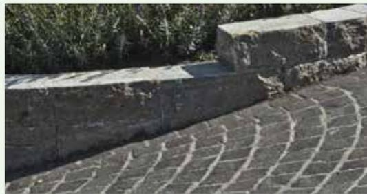
Durch diese Möglichkeit die Fließkonsistenz einzustellen, eignet sich vdw 800 hervorragend für starke Gefälle.
