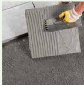
Bei Platten unterseitig vdw Universal-HaftBrücke auftragen
