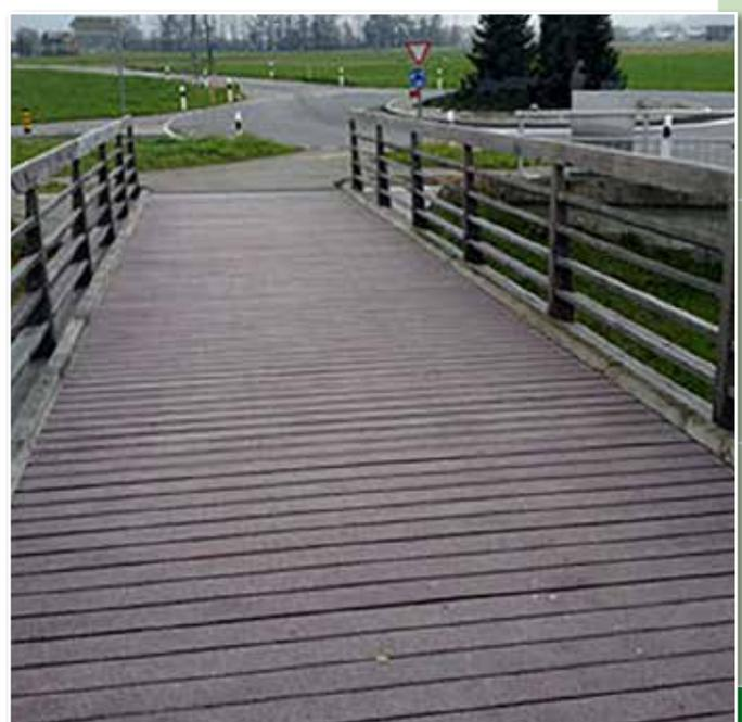
Mit **vdw 780** bieten wir Ihnen ein Holzbrückenbeschichtungssystem auf Epoxidharzbasis, welches speziell für den Einsatz auf Holzbrücken, Stegen und Terrassen entwickelt wurde. Es kann sowohl bei bestehenden Konstruktionen, wie auch bei Neubauten eingesetzt werden.
