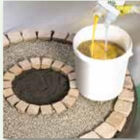
Oberfläche reinigen, Splittbinder dem Mineralstoff zugeben
