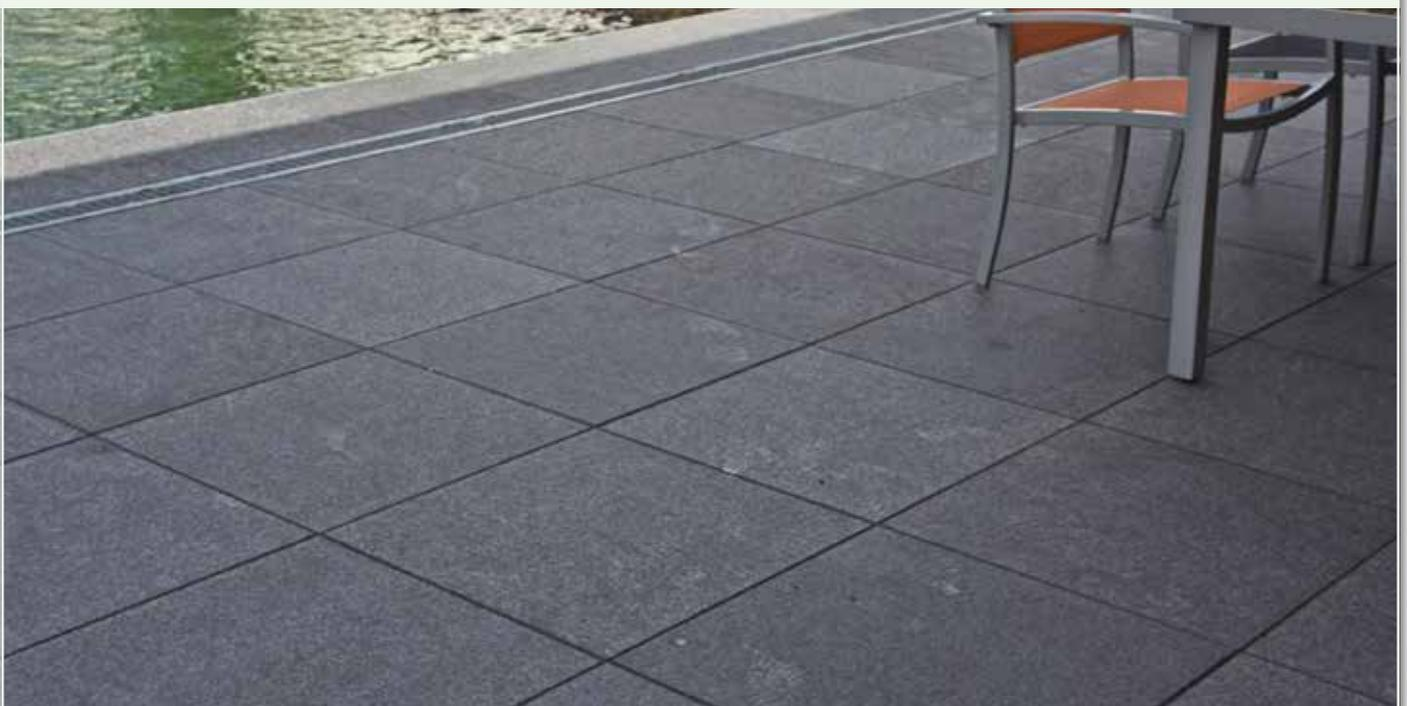
Für die Ausbildung von Dehnungsfugen in Pflaster- und Plattendecken existieren keine exakten Vorgaben in den relevanten Regelwerken. Dehnungsfugen werden häufig nicht ausreichend genau geplant. Durch thermische Längenänderungen der Pflasterdecke entstehen Spannungen im Belag, die sich jedoch nur annähernd berechnen lassen.
