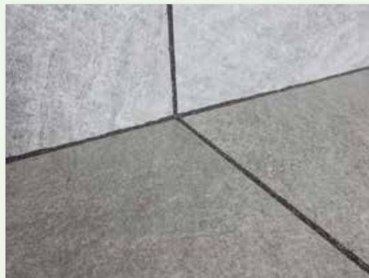
In der Variante **vdw 380 PolyfugenFlex** ist das Produkt gießfähig und selbstnivellierend und geeignet für die Abdichtung horizontaler Bodenfugen mit Gefälle von maximal 3 %.
