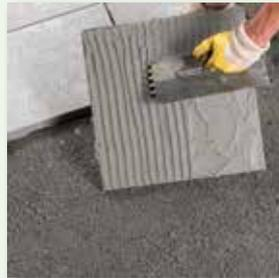
Bei Platten unterseitig vdw Universal-Haftbrücke auftragen
