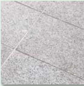
Klebebänder direkt im Anschluss entfernen; Nachbehandlung beachten
