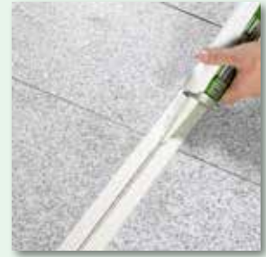
Fugenmasse einbringen
