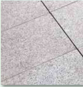
Oberfläche und Fugenflanken vorbereiten
