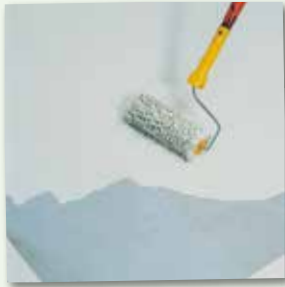
Die 2. Applikation frühestens nach ca. 12 Stunden auftragen
