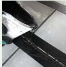
vdw 380 PolyfugenFlex in die Fuge gießen
