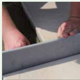
vdw 884 FugenBand im Bettungsmörtel einbringen
