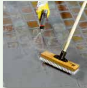
diagonal zur Fuge abreinigen
