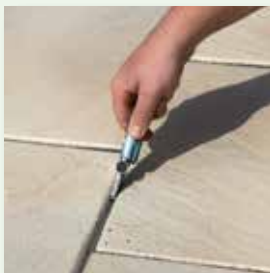
Hierzu Schnittkante FugenBand einkerben
