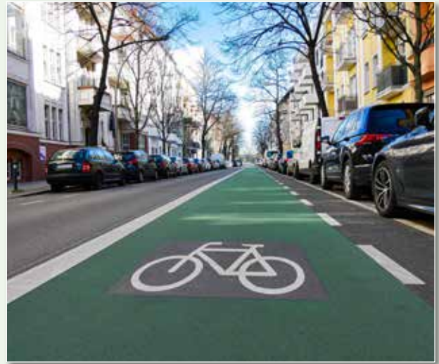
Für mehr Sicherheit – Berlin Neukölln & Treptow-Köpenick mehrere 10.000 m 2 grüne Radwege – im Gefahrenbereich wird der Radweg rot ausgeführt
