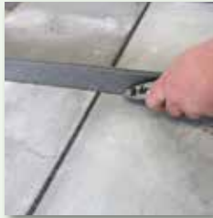
Dehnungsfugenband \geq 10 mm tief freischneiden
