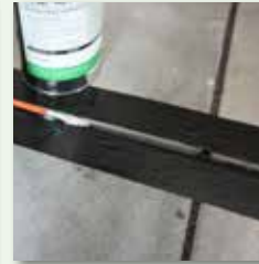
Fugenflanken mit Primer grundieren
