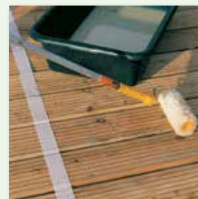
Mittels Fellrolle verteilen
