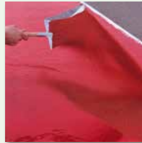
Im frischen Zustand mit Abstreusand abstreuen
