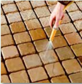
Fläche rückstandsfrei reinigen und vornässen
