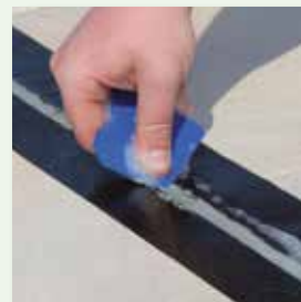
Fugenmasse verdichten und abziehen
