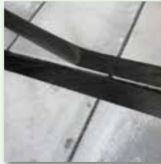
Fugenraum säubern und Kanten abkleben
