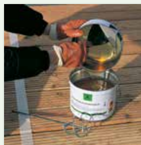
Komponente B in Komponente A einfüllen und gründlich durchmischen
