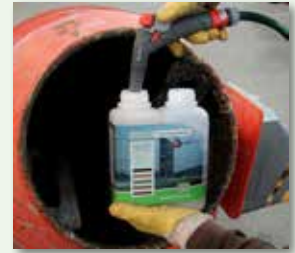
Max. 1 l Wasser hinzufügen und homogen anmischen
