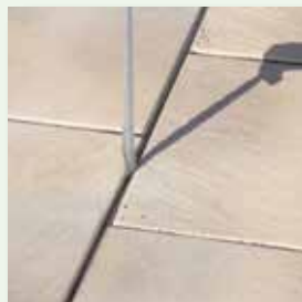
Fugenbandreste komplett entfernen
