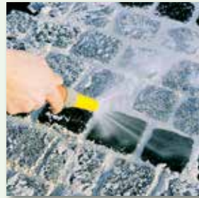
mit Wassersprühstrahl und feuchtem Besen abreinigen
