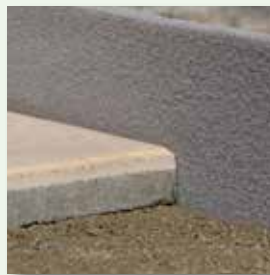
Anschließenden Belag druckfrei verlegen
