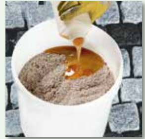
Bindemittelkomponente zugeben
