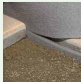
vdw 884 FugenBand 10 mm tief abtrennen
