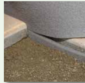
vdw 884 FugenBand 10 mm tief abtrennen
