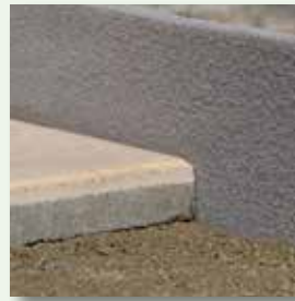
Anschließend den Belag druckfrei verlegen
