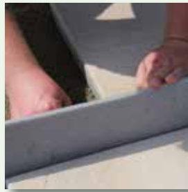
vdw 884 FugenBand im Bettungsmörtel einbringen
