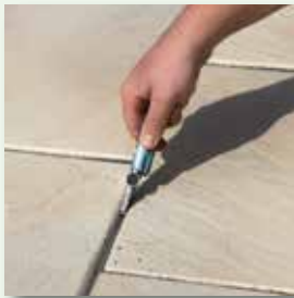
Hierzu Schnittkante FugenBand einkerben
