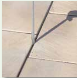
Fugenbandreste komplett entfernen
