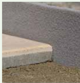
Anschließend den Belag druckfrei verlegen
