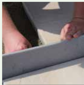
vdw 884 FugenBand im Bettungsmörtel einbringen
