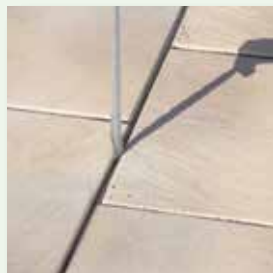
Fugenbandreste komplett entfernen
