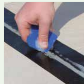
Fugenmasse verdichten und abziehen
