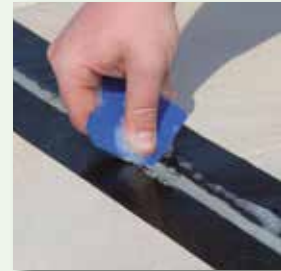
Fugenmasse verdichten und abziehen
