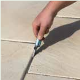
Hierzu Schnittkante FugenBand einkerben
