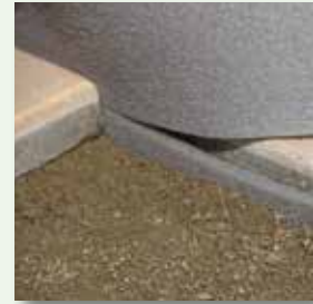
vdw 884 FugenBand 10 mm tief abtrennen
