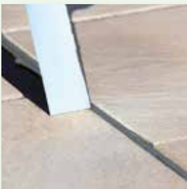
Klebebänder direkt im Anschluss entfernen
