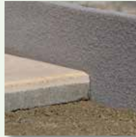
Anschließend den Belag druckfrei verlegen
