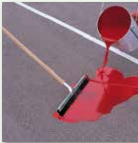
Material vollständig ausbringen und mit Gummischieber verteilen
