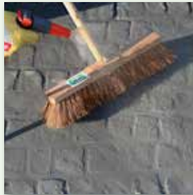
Erhärten des Mörtels auf der Oberfläche vermeiden
