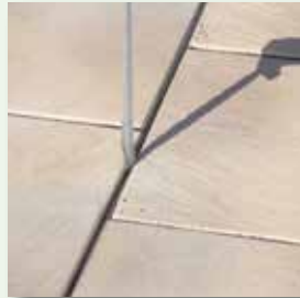
Fugenbandreste komplett entfernen
