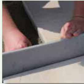
vdw 884 FugenBand im Bettungsmörtel einbringen
