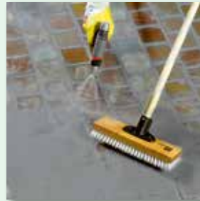
diagonal zur Fuge abreinigen
