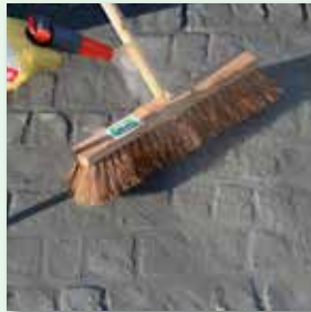
Erhärten des Mörtels auf der Oberfläche vermeiden
